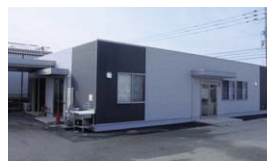
福岡南SC (2016年建替え工事を実施)
