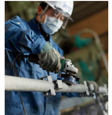
部材整備の様子(埼玉整備工場)
