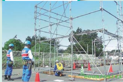
関東地区で開催した第9回から一級検定を開 始。受検者には、二級の合格に加え、更に高度な 施工技能、指導教育能力及び高度なコミュニケ ーション能力が求められる。
